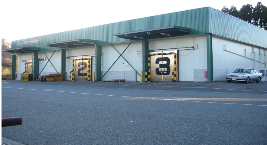
民間資金導入の例（青果部卸売業者が建設・管理している保冷倉庫）
