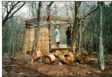
間伐材の利用(小屋)
